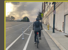
Infraestructura Para Bicicletas Bike Facilities
